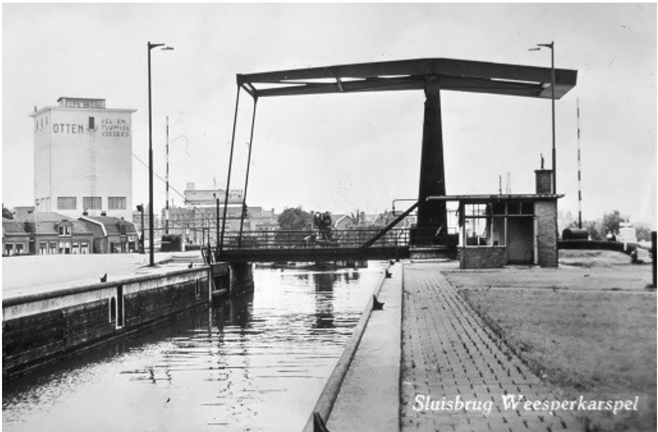
De nieuwe brug en sluis.
